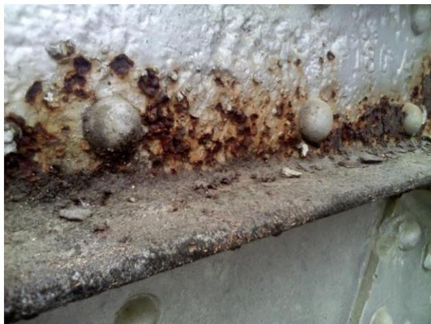
Figura 1: Corrosão em viga de aço carbono em ponte.
